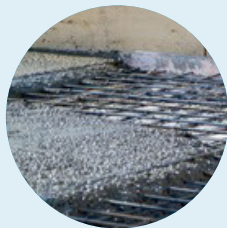
Stahlbeton Stahlanteil: 5 - 10 kg/m 2
