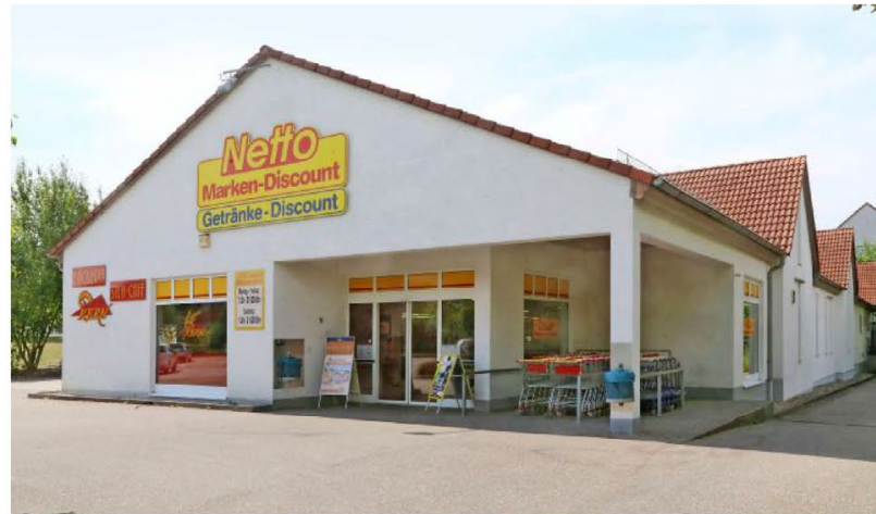
17 Jahre alt ist das Gebäude an der Straße Zwerchäcker in Affaltrach. Der Neubau soll die Kundenfreundlichkeit erhöhen.
