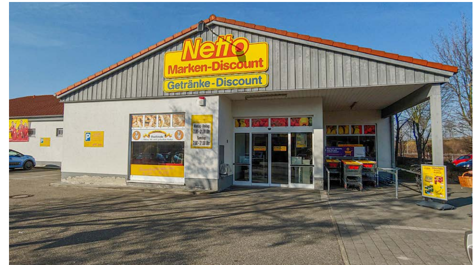
Bestandsmarkt vor dem Umbau
